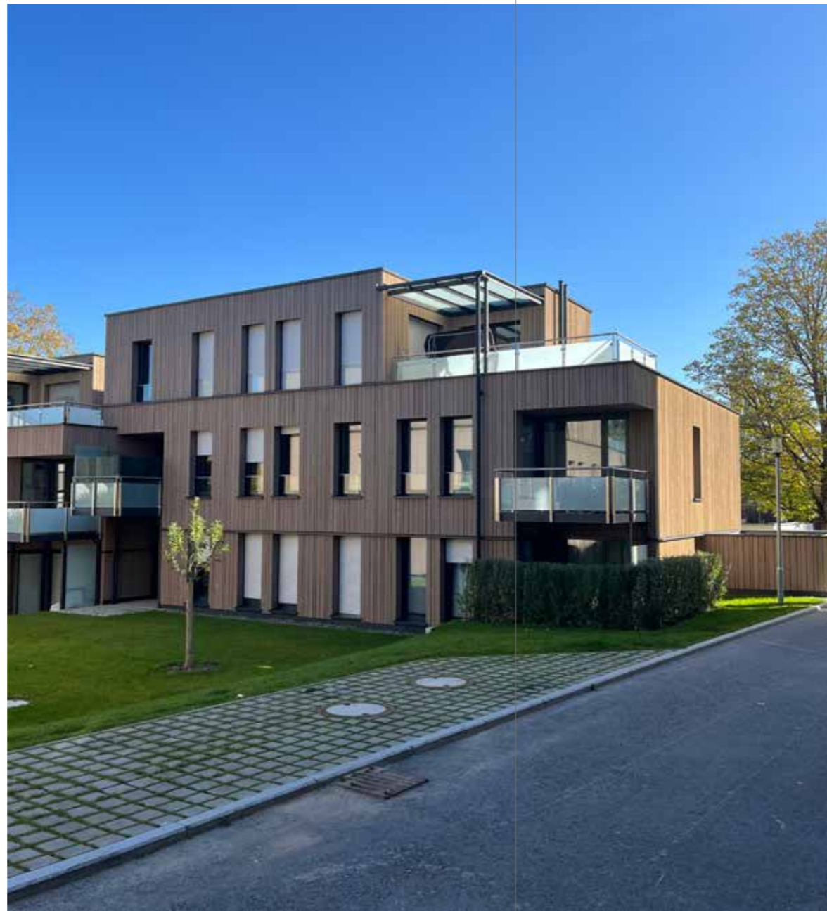
Eines der drei Holzhäuser des LuisenQuartiers in Villingen-Schwenningen
