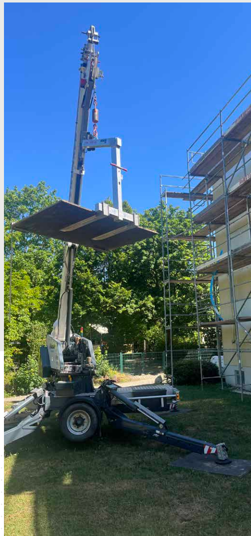
Umfassende Sanierung der Gebäude in der Wöschhalde in Villingen-Schwenningen.
